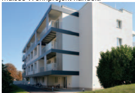
Das Haus der Schwestern in Wien wurde gründlich saniert.
