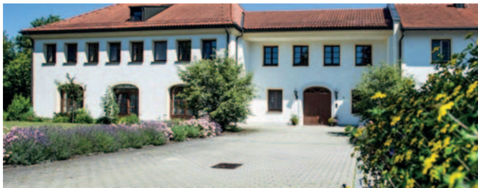
Mutterhaus der Missionsschwestern in Stadl bei Gars a. Inn
