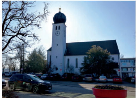
Pfarrkirche in Vaterstetten
