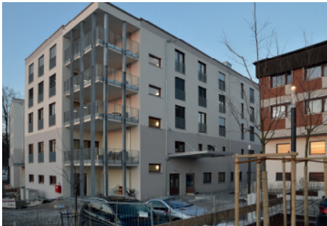
Neubau des Altenheims St. Michael in Cham
